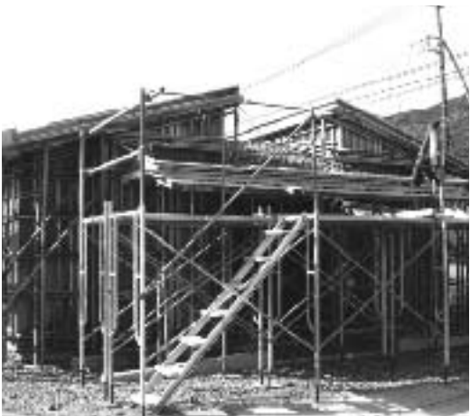
下二小グラウンドトイレ改修工事風景
