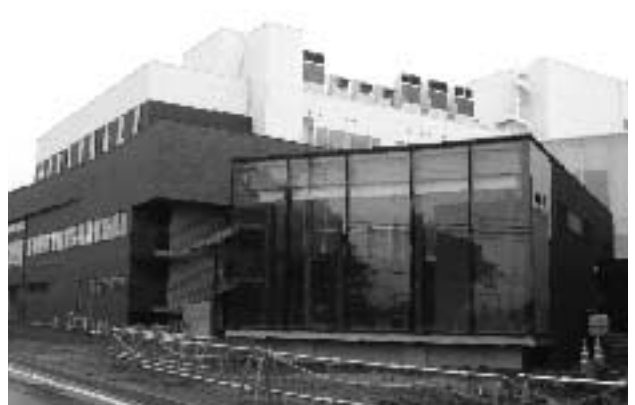
建設中の市立図書館
