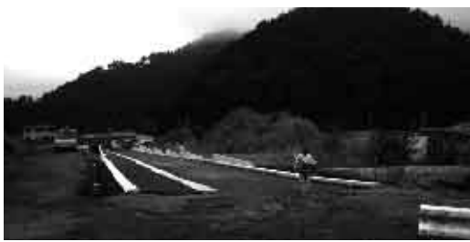
大明見下の水線二期工事 施工風景
